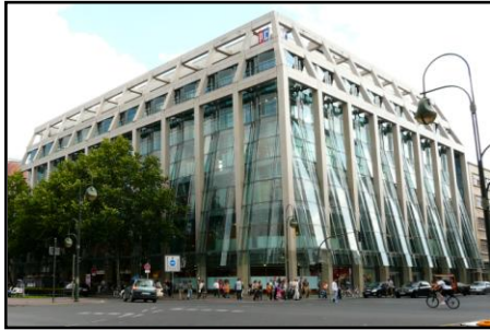
مبنى متجر بيك وكلوبينبرغ برلين Peek and Cloppenburg Department Store, Kurfürstendamm، يتميز بواجهاته المقامه من الزجاج حيث تتسم بالشفافية والفخامة المعمارية
